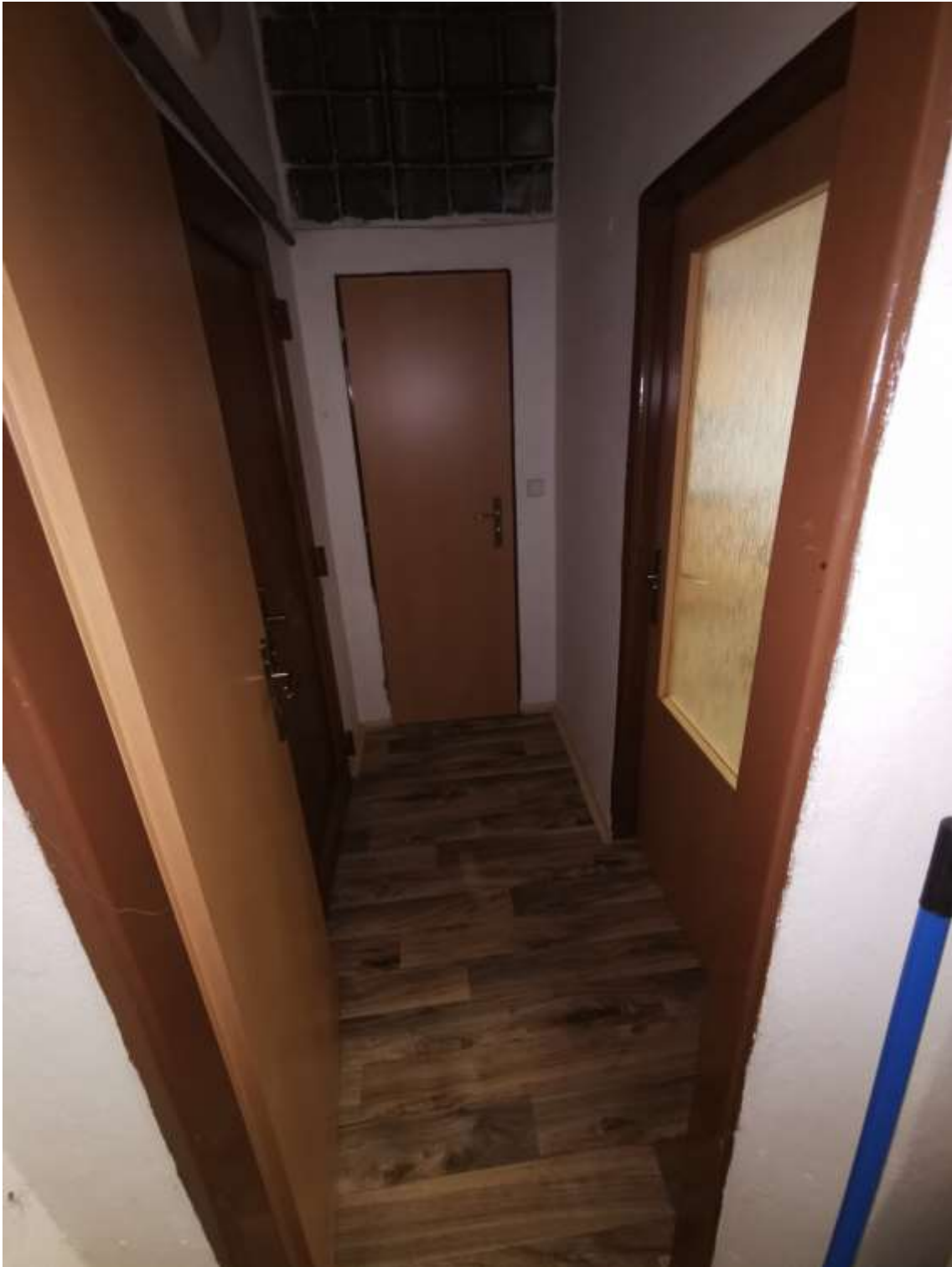
Nové dveře do WC, učebny a garáže techniky
